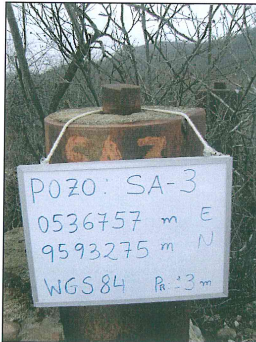
Fotografía N° 1. Pozo inactivo, con casing que sobresale 1 m sobre el nivel de la superficie del suelo.
