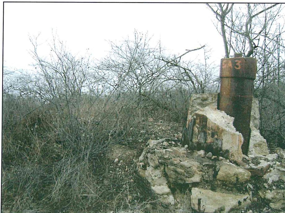
Fotografía N° 2. La zona evaluada se caracteriza por tener una topografía ligeramente ondulada, dentro de un bosque seco ralo, se evidencia cemento en la parte inferior del casing.
