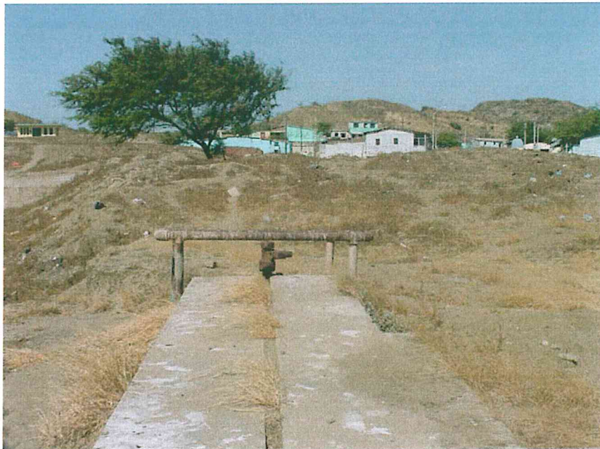
Ver posible rehabilitación.
