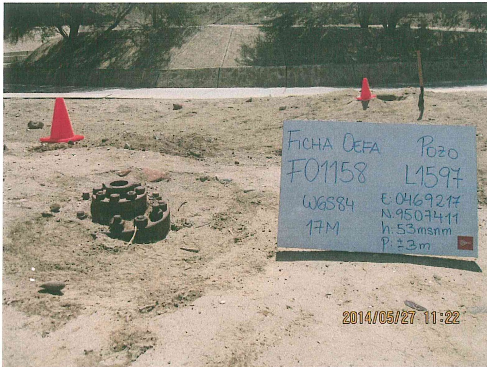
Fotografía N° 1. Pozo L1597, presenta casing con brida parcialmente enterrado.
