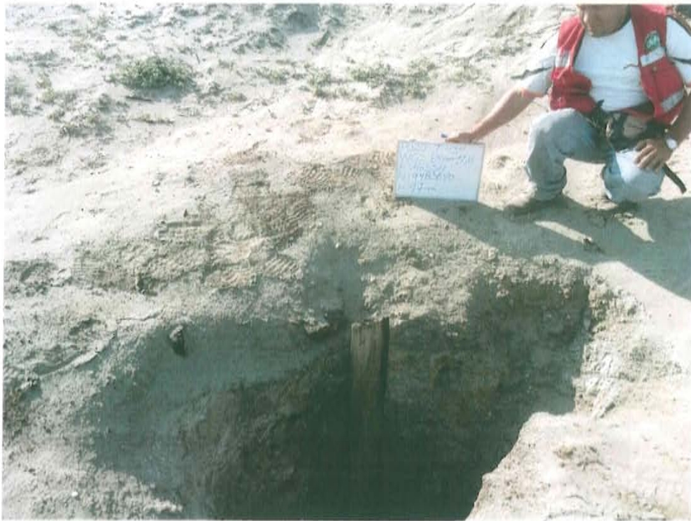
Fotografía N° 1. El Pozo T_434, se encuentra en una excavación de 1,5 m x 1 m x 1,5 m de profundidad.
