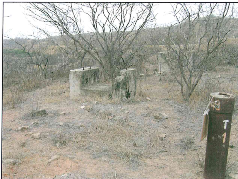
Fotografía N° 2. Estructuras de cemento encontradas cercanas al pozo.
