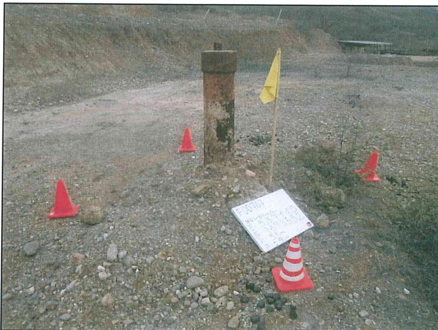
Fotografía N° 1. Pozo inactivo y mal abandonado encontrándose el casing sobre la superficie.
