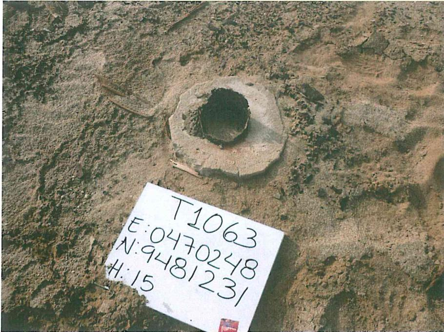
Fotografía N° 1. Pozo mal abandonado con código PERUPETRO T1063, presenta tubo interno corroído a nivel del suelo rodeado de cemento y con acumulación de tierra en su interior.
