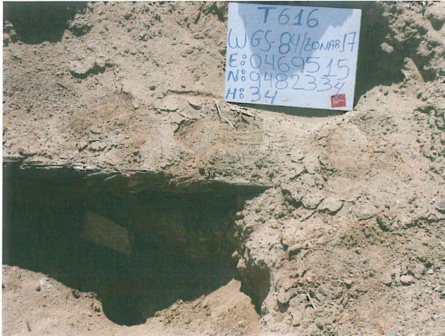
Fotografía N° 1. Pozo inactivo mal abandonado, sin cabezal, con casing superficial a nivel de suelo dentro de un hoyo de 0,67 m de profundidad.
