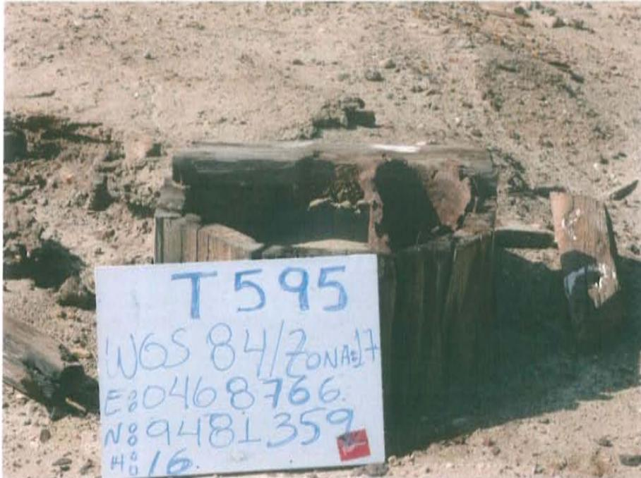
Fotografía N° 1. Pozo inactivo mal abandonado, sin cabezal, con casing corroído rodeado con tablonces de madera, no sellado herméticamente.
