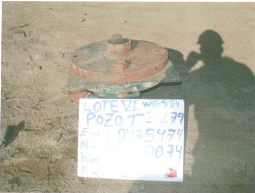
Fotografía N° 2. Descripción de la ubicación georeferenciada del pozo T3279.
