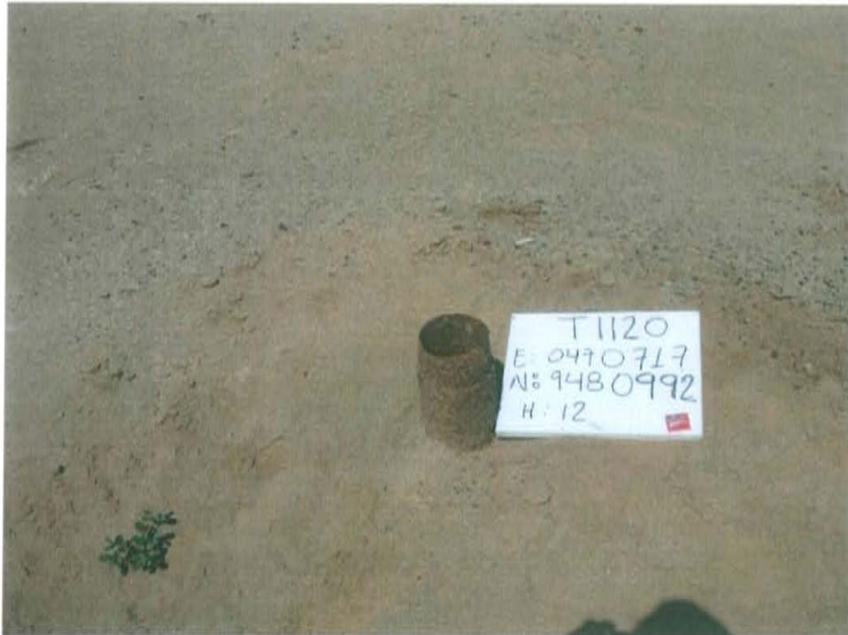
Fotografía N° 1. Pozo mal abandonado con código PERUPETRO T1120, sin cabezal, con tubo expuesto de 0,25 m sobre el nivel del terreno.
