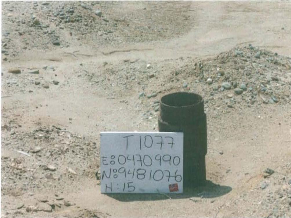
Fotografía N° 1. Pozo inactivo con código T1077, sin cabezal, con tubo expuesto de 0,43 m sobre el nivel del terreno.
