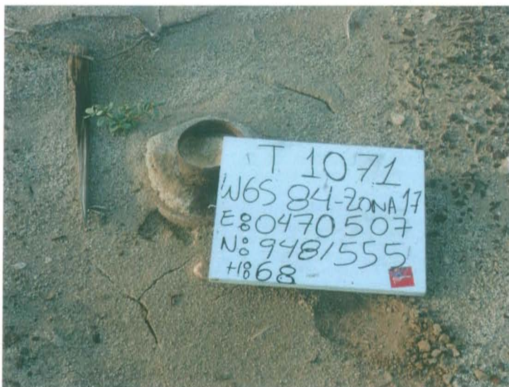
Fotografía N° 1. Pozo inactivo, presenta casing cementado y tubo interno con acumulación de tierra su interior.
