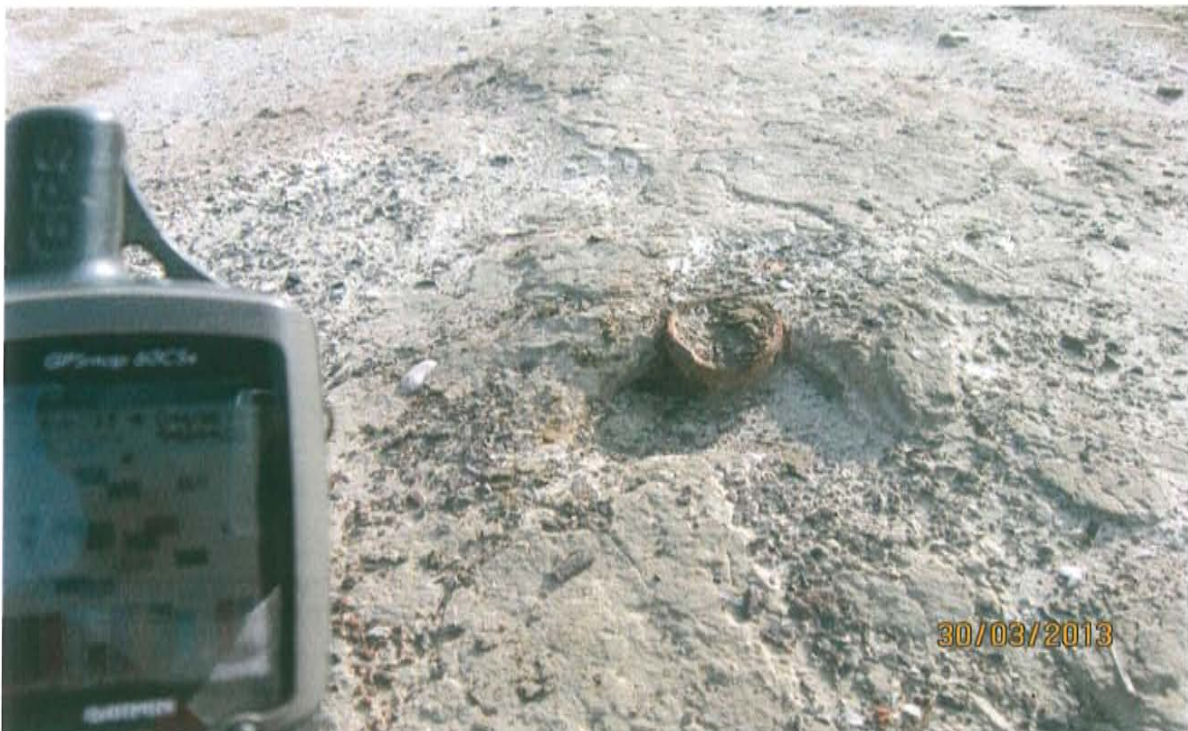
Fotografía N° 2. El Pozo T__70, se encuentra abandonado con casing corroído y cubierto en el interior con tierra.
