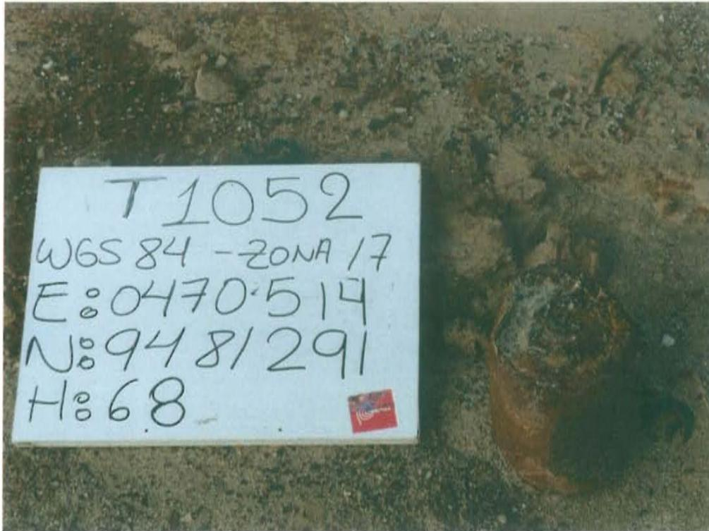
Fotografía N° 1. Pozo inactivo, con tubo expuesto que sobresale 0,23 m sobre el nivel del terreno, corroído y con acumulación de tierra en su interior.
