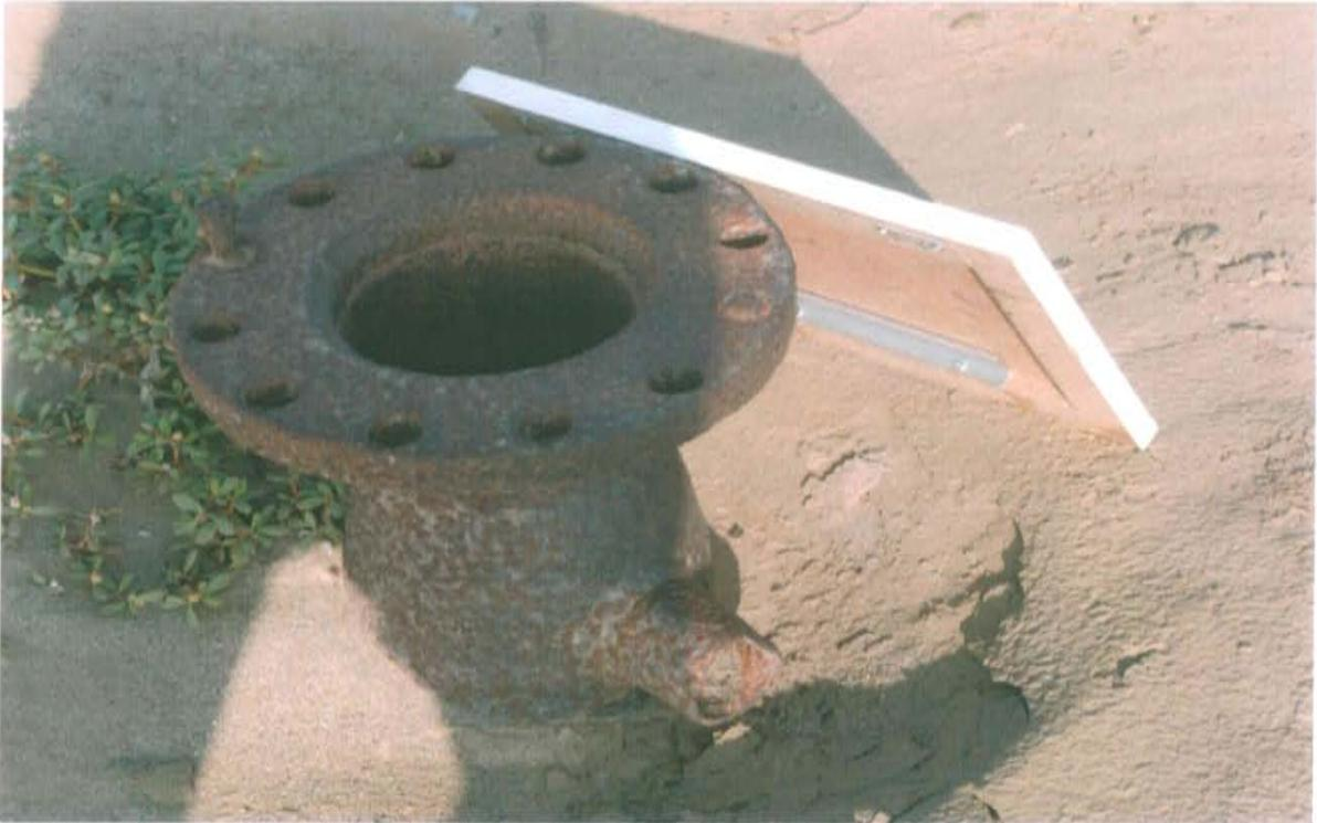
Fotografía N° 1. Se observa el Pozo con código PERUPETRO T1368 mal abandonado con el casing y brida corroídos, abierto en la parte superior con presencia de vegetación a su alrededor.
