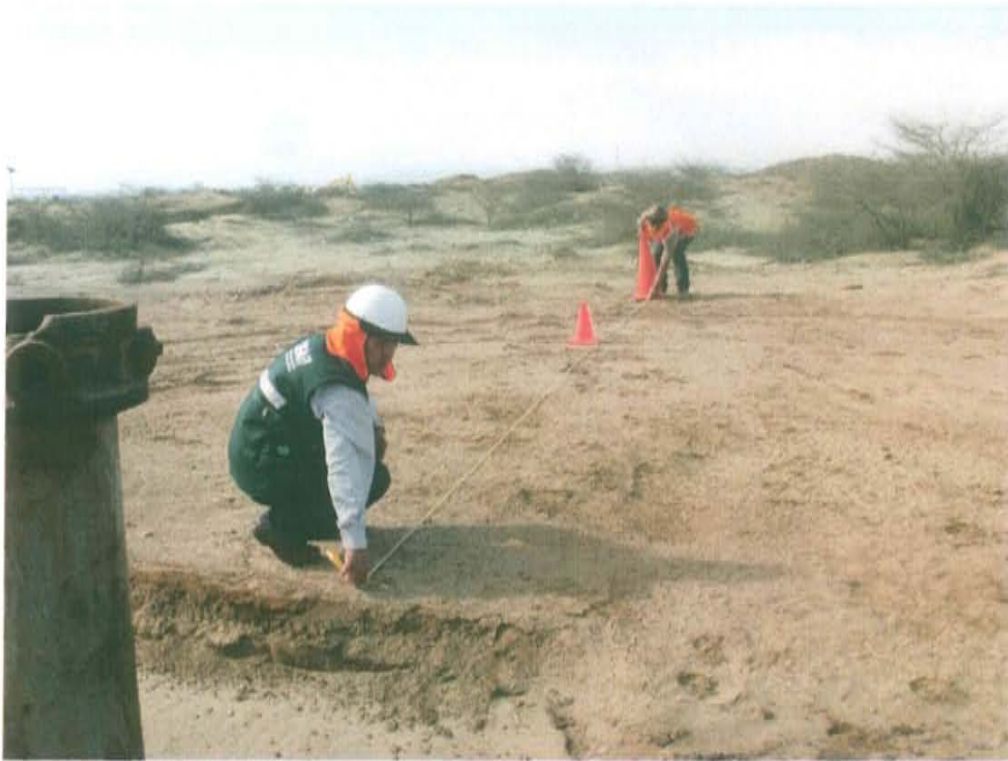
Fotografía N° 3. La vegetación ha sido desbrozada para la rehabilitación del terraplén.
