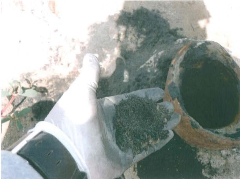
Fotografía N° 3. Acumulación de tierra con residuos de hidrocarburos al interior del Pozo T1097.
