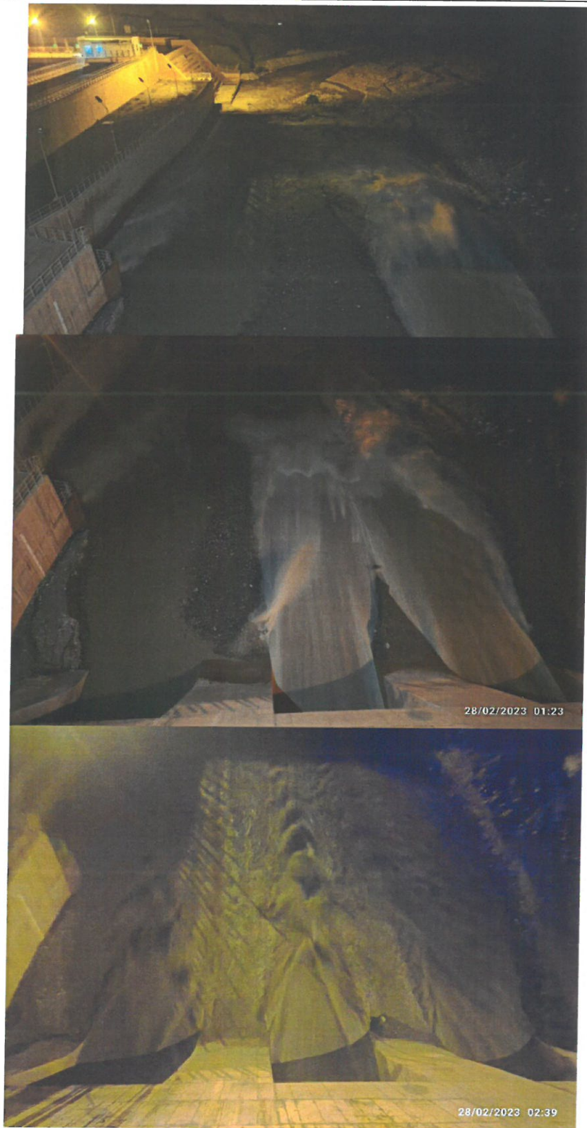
Imagen N° 4: Vista de la Presa Checras durante la purga de sedimentos con la apertura Nos. 1, 2 y 3 compuertas radiales del embalse.
