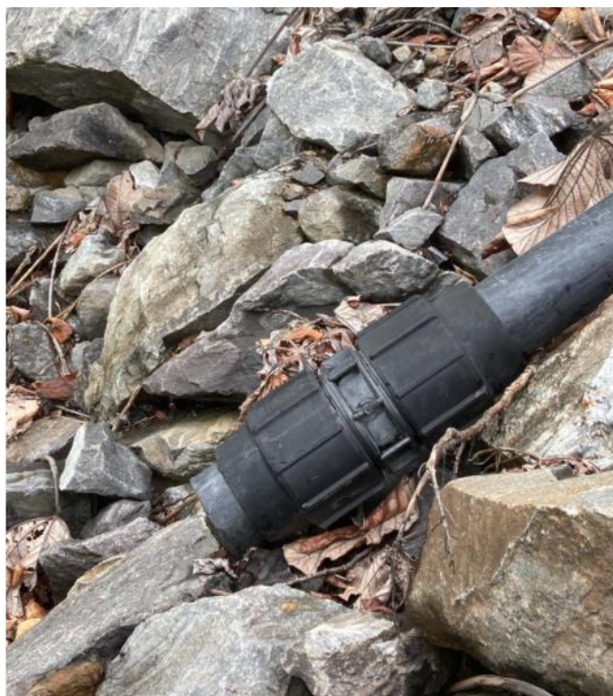
Fotografía 2: Tubería auxiliar desacoplada
