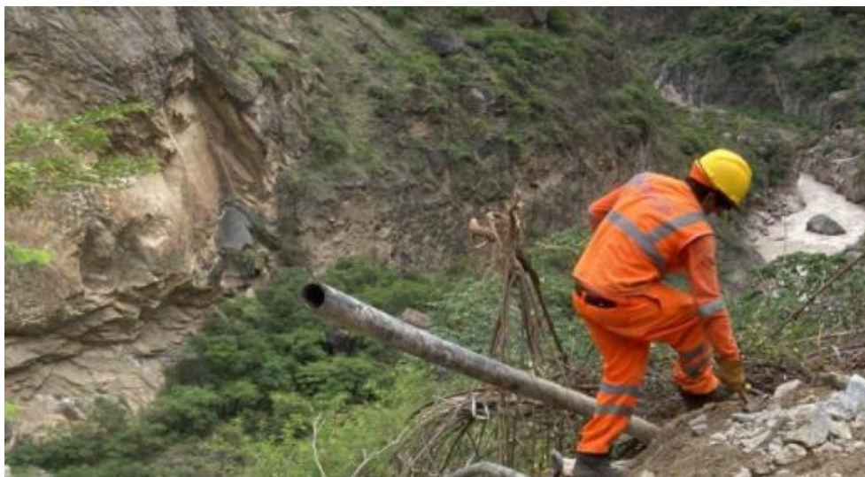
Fotografia 1 : Tuberia auxiliar cortada y en proceso de retiro
