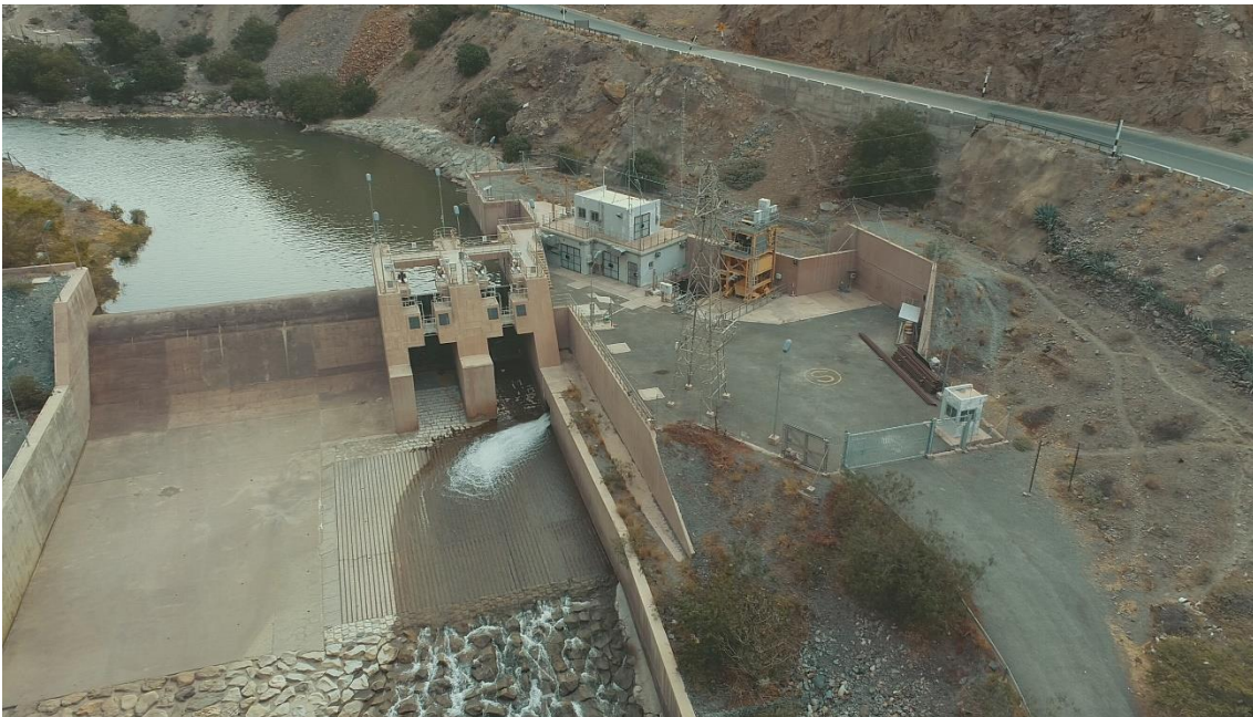
Figura 7.16. Reservorio Huaura de la central Hidroeléctrica Cheves
