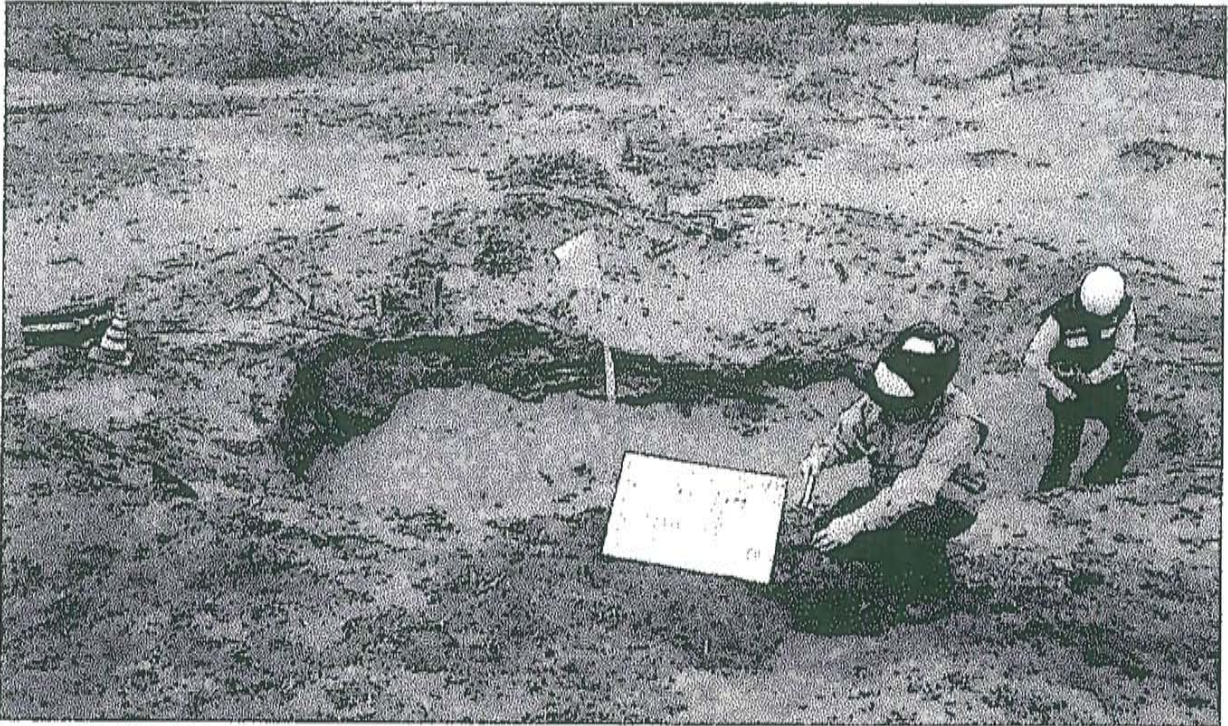
Fotografía N° 1. Toma de muestra de suelo en el punto F00515-SU01, ubicado a 6 m al oeste aproximadamente del Pozo T1566.
