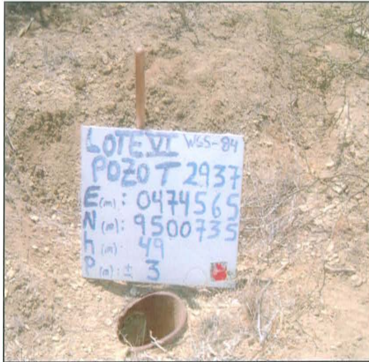
Fotografía N° 1. Se observa pozo abierto, mal abandonado, al ras del suelo.
