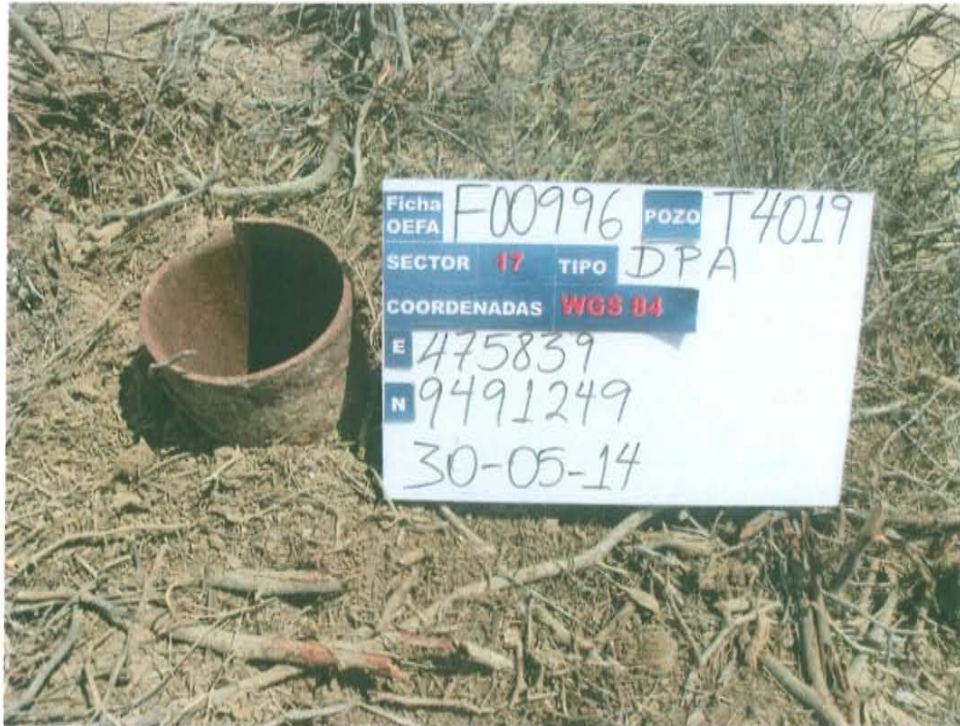
Fotografía N° 1. Pozo T4019, presenta casing abierto de 10 pulgadas aproximadamente.
