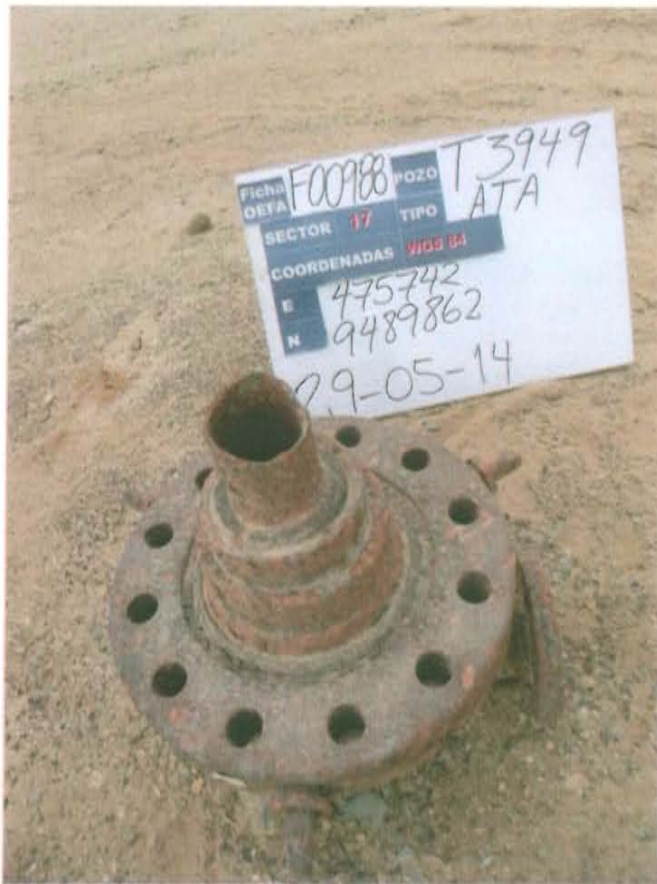
Fotografía N° 1. Se observa Pozo T3949 con tubo de producción abierto.
