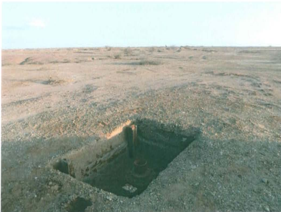
Fotografía N° 2. El Pozo T4049, se ubica en una zona de terraplén, con escasa vegetación alrededor del pozo.
