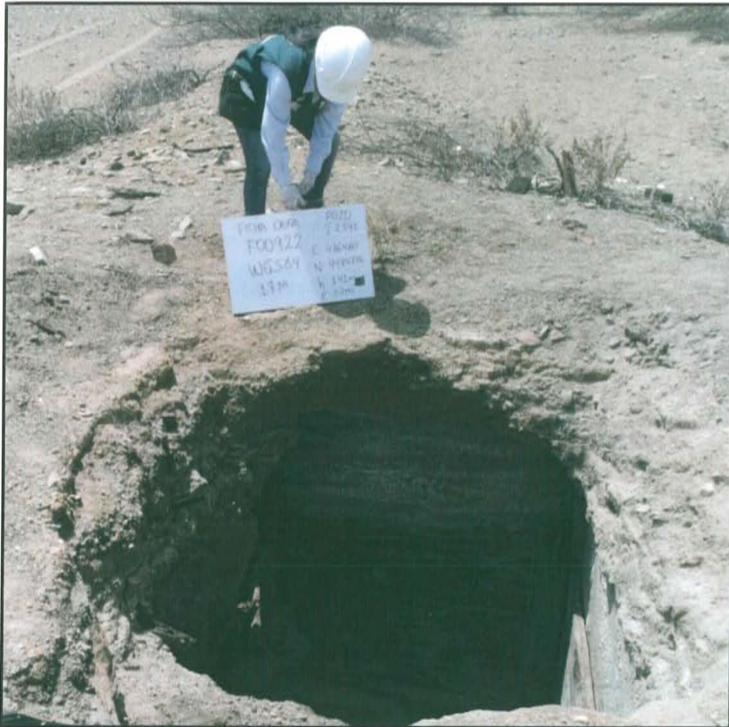
Fotografía N° 1. Pozo T2393 con casing no visible.
