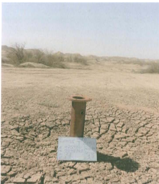
Fotografía N° 1. Pozo inactivo sin casing y cabezal ni válvula que sobresale 1 m sobre la superficie del suelo.
