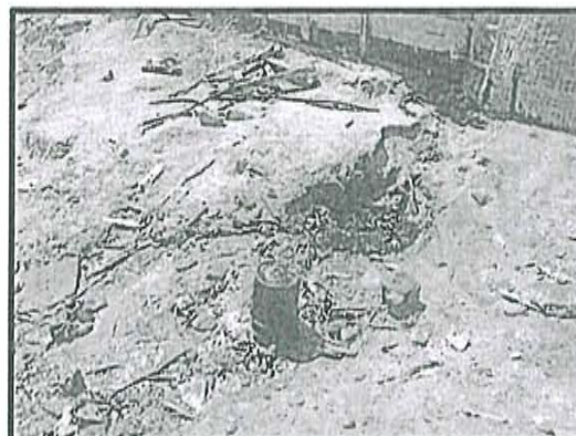
Foto 24: Presencia de crudo en el suelo.
