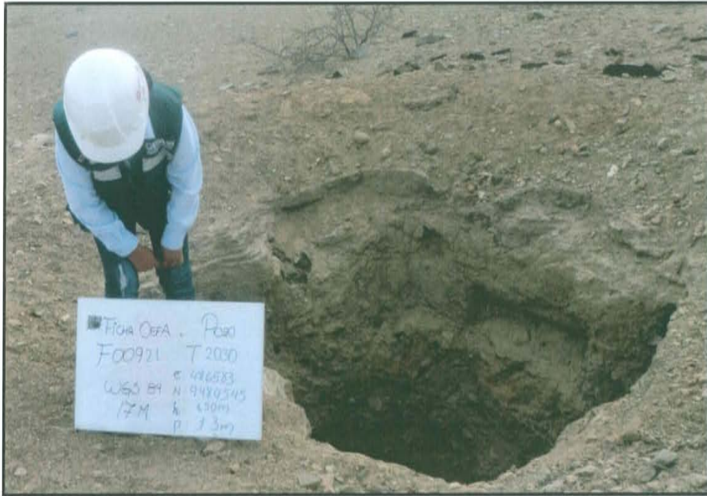
Fotografía N° 1. Pozo T2030 presenta casing de 1,5 m de altura que se encuentra dentro de un hoyo de 6 m de profundidad.
