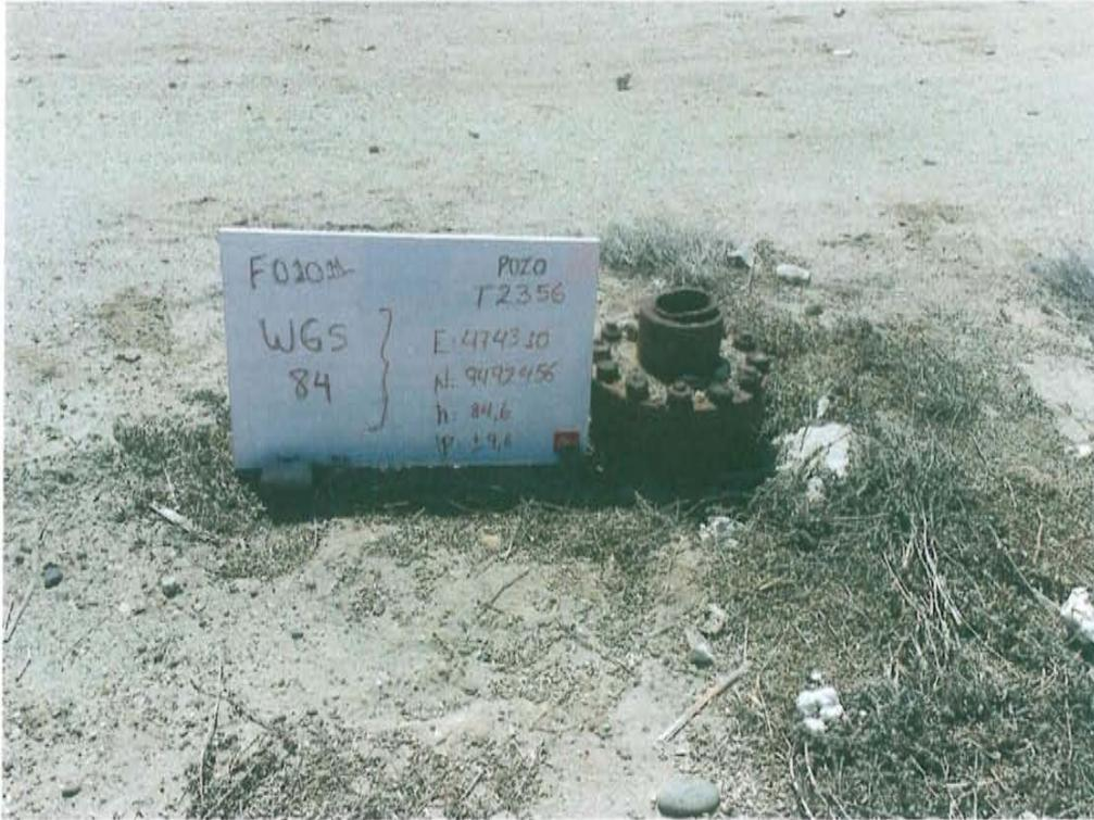
Fotografía N° 1. Identificación del pozo inactivo con código PERUPETRO T2356, presenta casing sin válvulas que aseguren su hermetismo.
