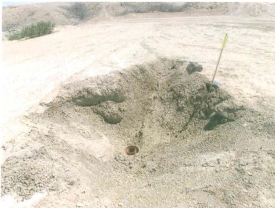
Fotografía N° 1. Se observa Pozo T 3404, con casing abierto al ras del nivel del suelo.
