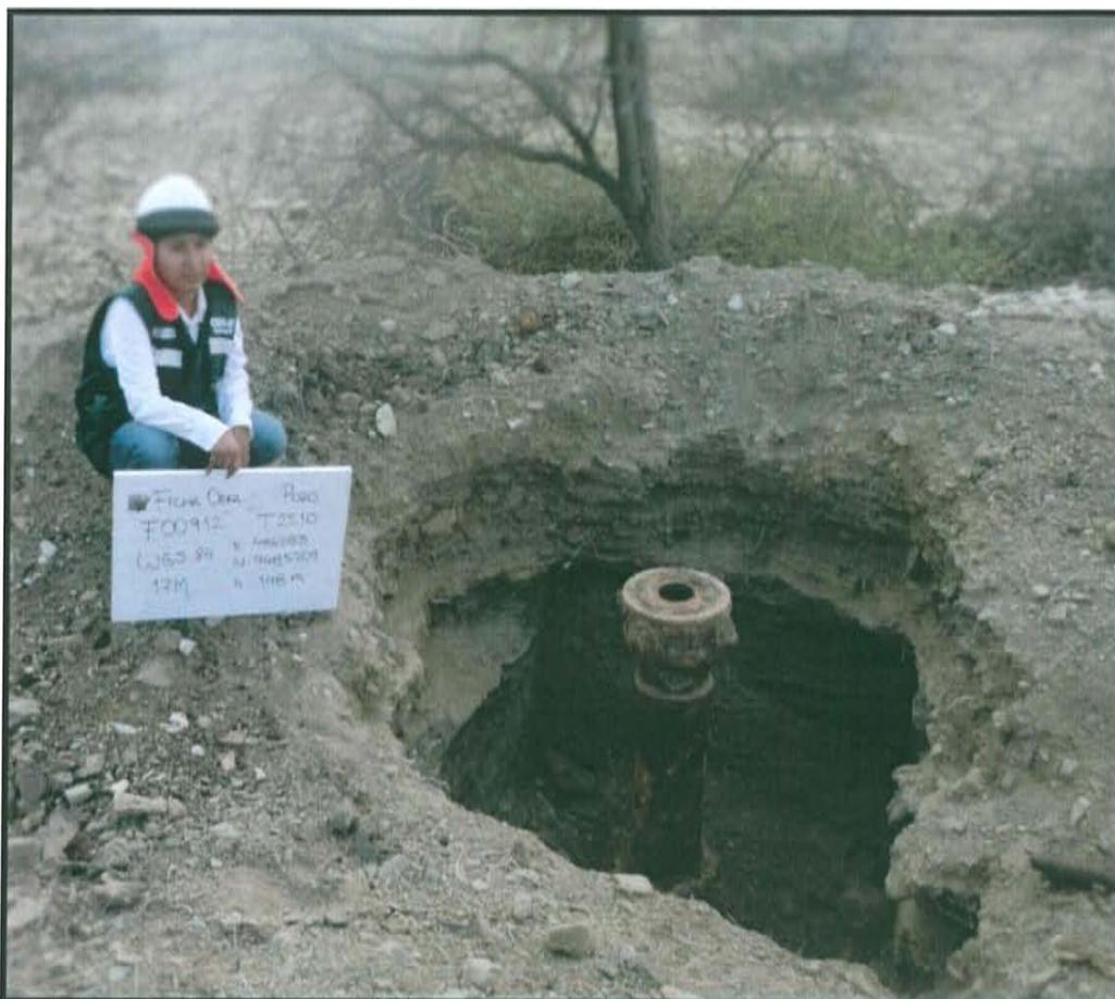
Fotografía N° 1.- Pozo T2510 presenta casing de 15 plg y 1,7 m de altura que se encuentra dentro de un hoyo de 1,8 m de profundidad
