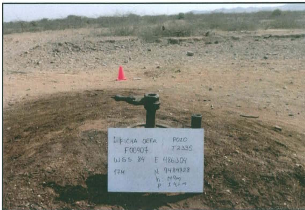
Fotografía N° 1.- Pozo T2335 presenta casing que sobresale 0,5 m sobre el nivel del suelo.
