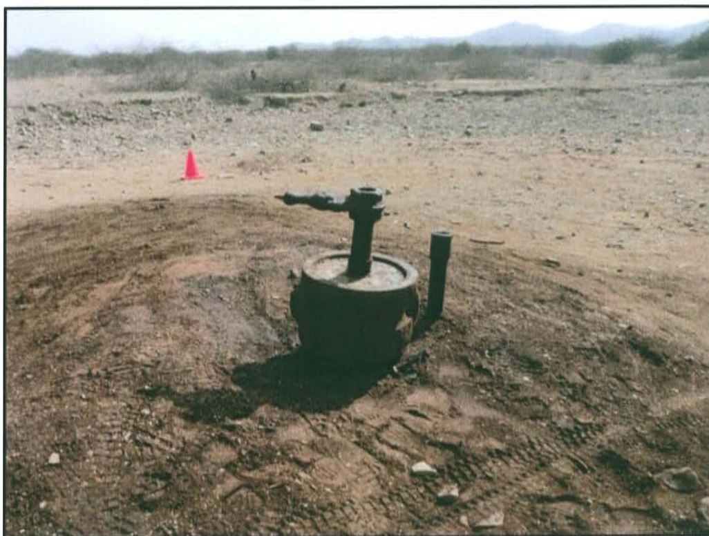
Fotografía N° 2.- Suelo impregnado con hidrocarburo a 3 m a la redonda del casing del Pozo T2335.
