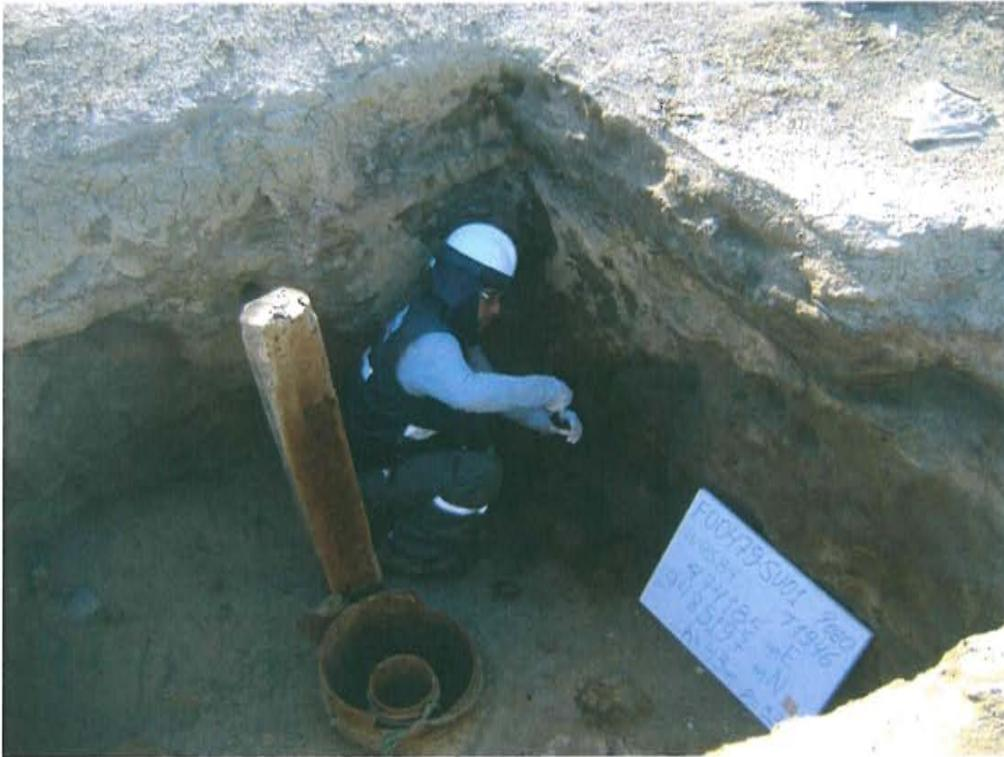
Fotografía N° 3. Toma de muestra en el punto F00479-SU01, ubicado a 0,5 m de distancia del pozo T1946.
