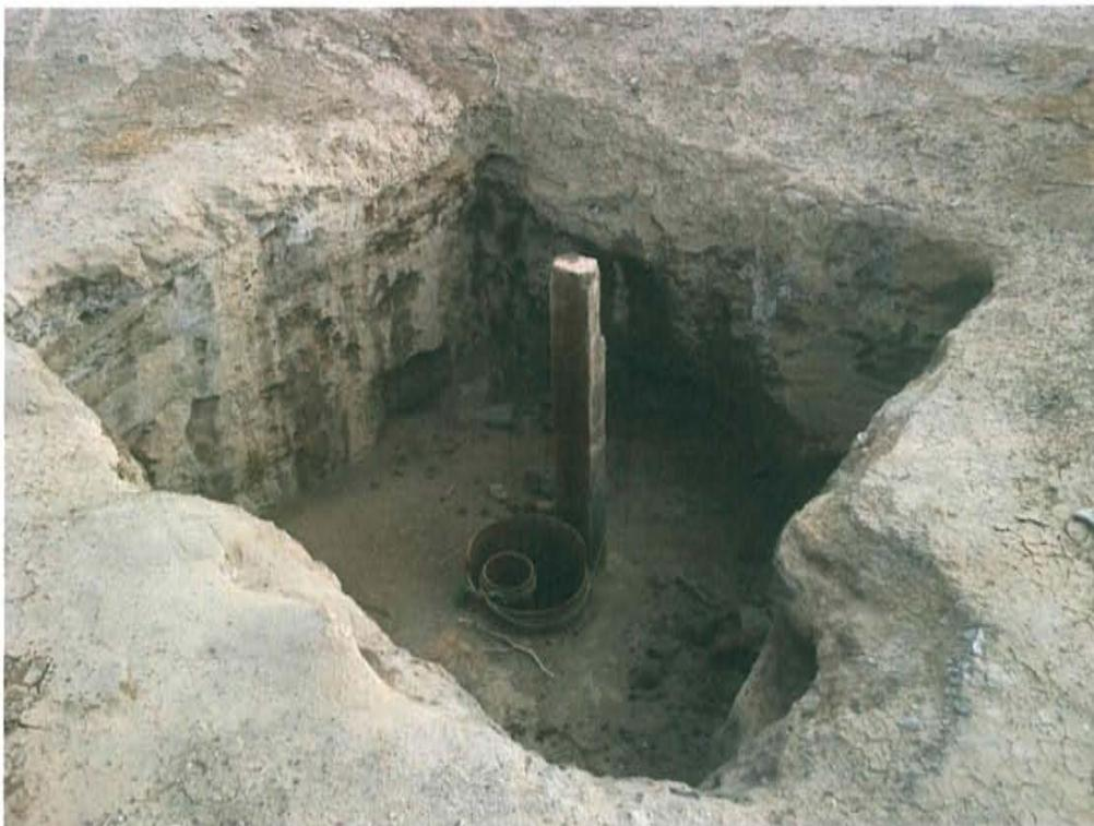
Fotografía N° 1. Pozo con código PETRUPETRO T1946 inactivo mal abandonado que se encuentran ubicado en una cantina con restos de madera.
