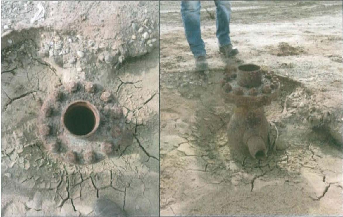
Fotografía N° 1. Pozo con código PETRUPETRO T1925 inactivo mal abandonado, donde se observa el casing que cuenta con brida.
