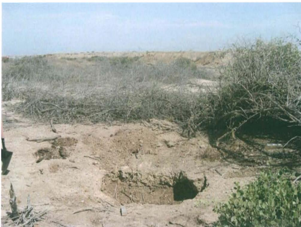
**Fotografía N° 1.** Vista de la ubicación de pozo T2879, se observa un hoyo donde se ubicó el casing posiblemente cortado.
