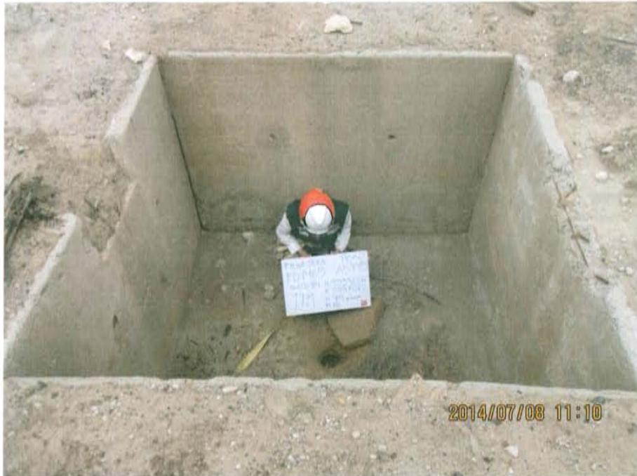
Fotografía N° 1. Pozo inactivo, se observa casing abierto a nivel del suelo, dentro de una cantina de cemento.
