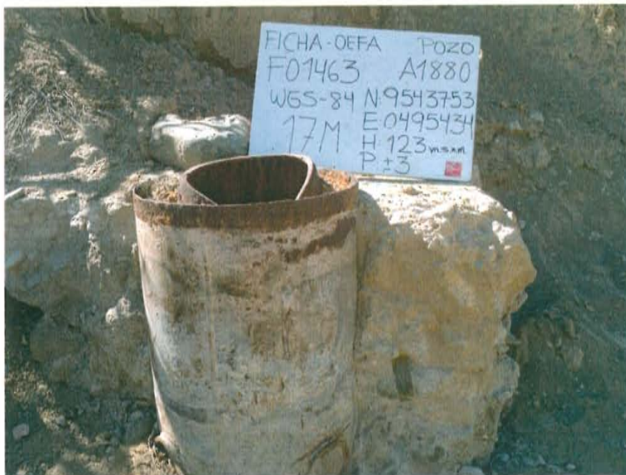
Fotografía N° 1. Se observa casing superficial e intermedio de 19 y 11 pulgadas de diámetro, respectivamente.
