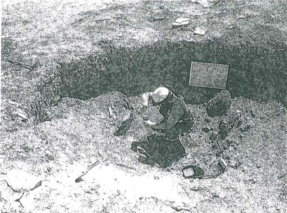
Fotografía N° 1. Toma de muestra de suelo en el punto F00518-SU01, ubicado a 1 m aproximadamente del Pozo T1652.
