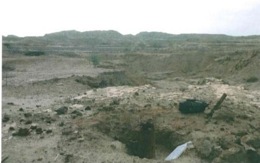
Fotografía N° 4. Se observa el Pozo T\_152, que presenta casing (tubo de revestimiento) corroído y ubicado dentro de hoyo,
