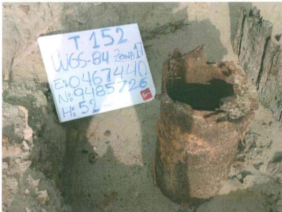
Fotografía N° 1. Pozo T\_152 mal abandonado, sin cabezal con tubo corroído.
