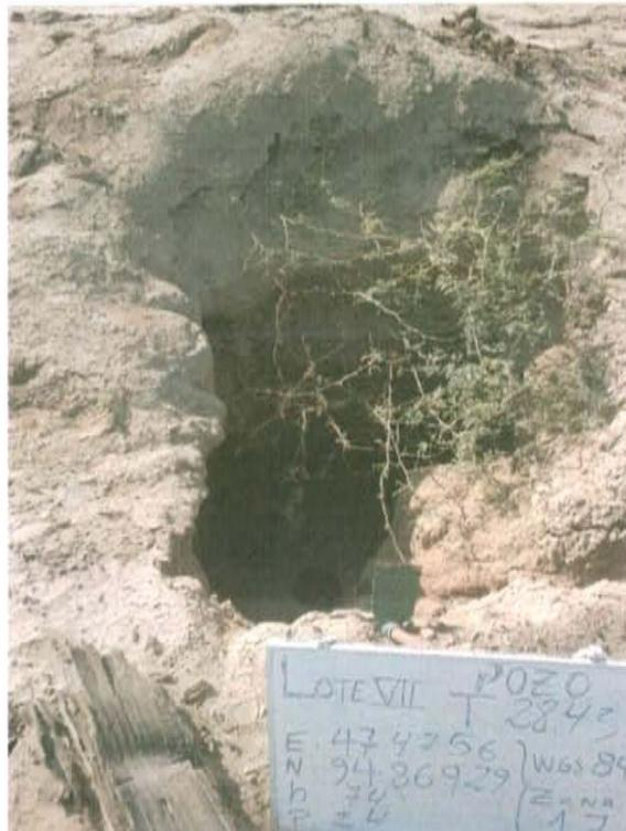
**Fotografía N° 1.** Vista del pozo T2843 ubicado dentro de un hoyo con el casing cortado al ras del suelo.
