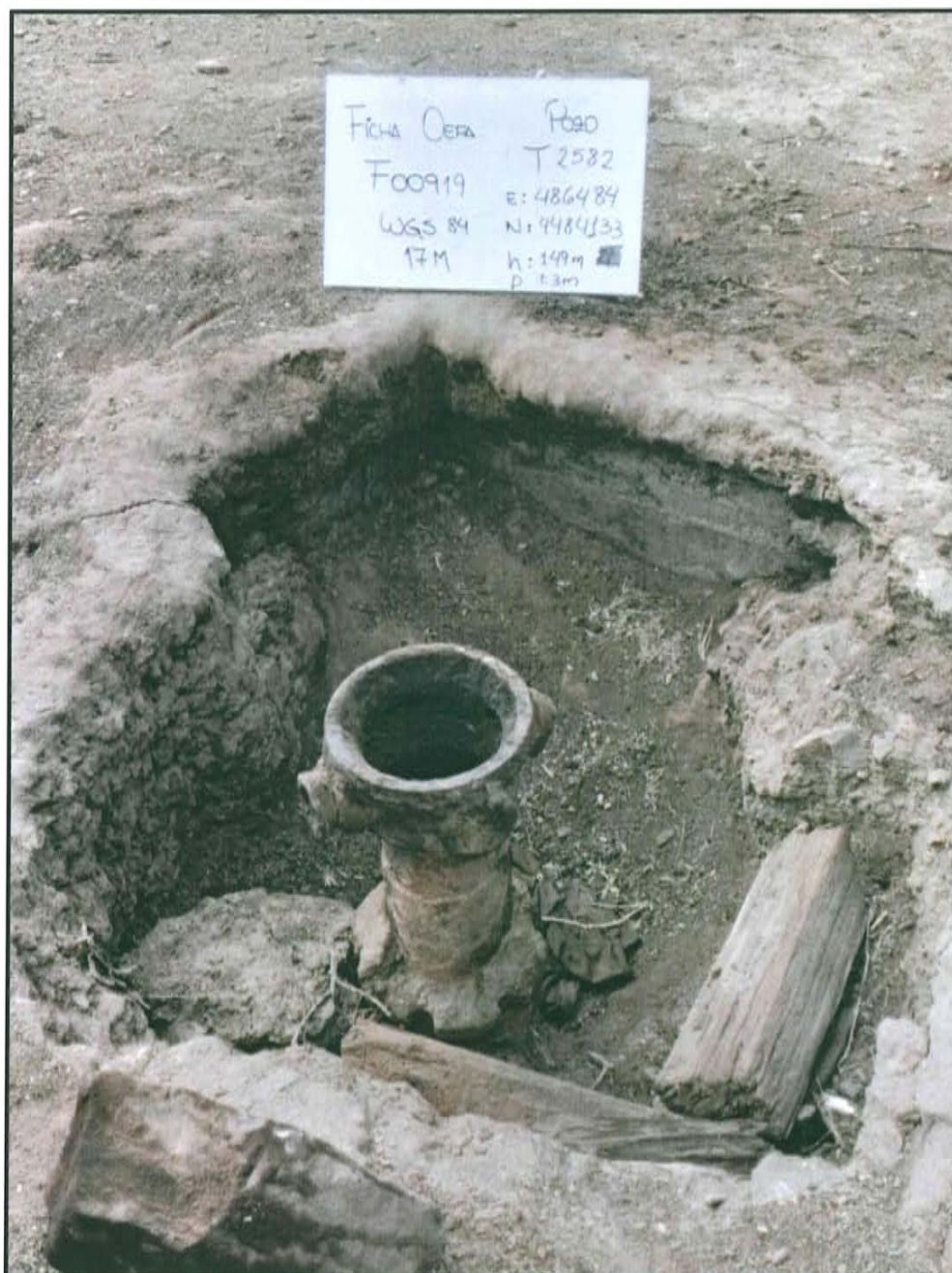
Fotografía N° 1.- Pozo T2582 presenta casing que sobresale desde la base de la cantina de 0,7 m de profundidad hasta la superficie del suelo.
