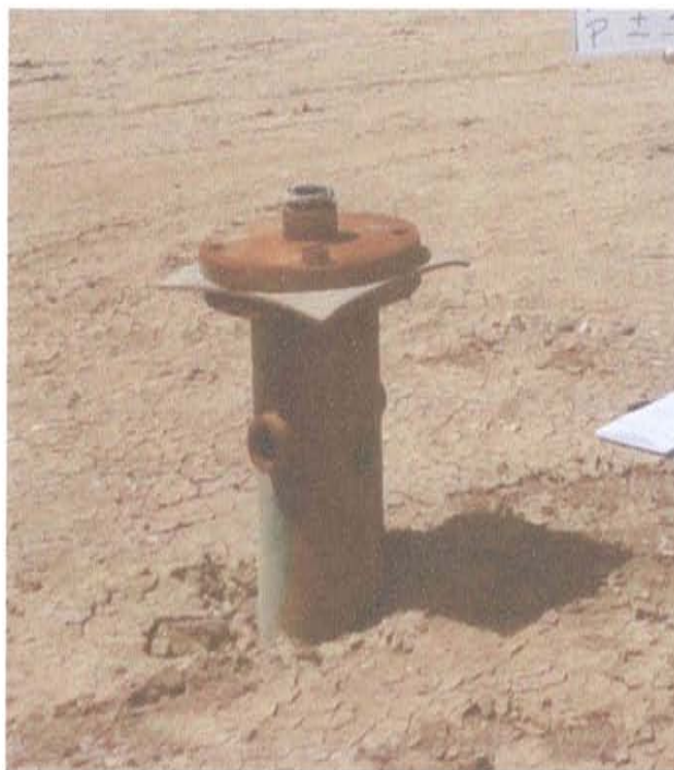
Fotografía N° 1. Vista del pozo petrolero inactivo, se observó que el casing sobresale en 0,6 m sobre el nivel del suelo.
