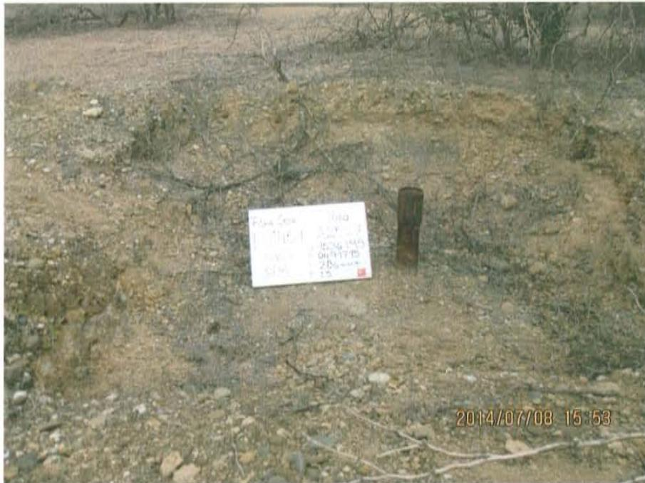
Fotografía N° 1. Pozo inactivo, con casing abierto que sobresale 0,47 m sobre el nivel del terreno.
