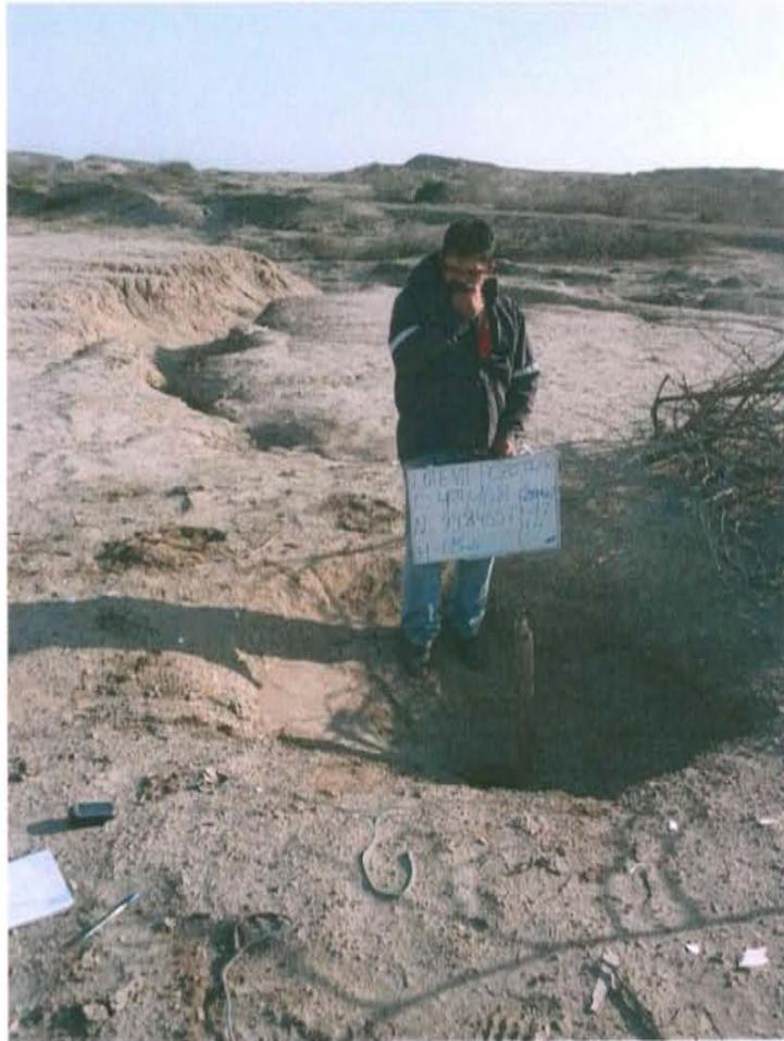
Fotografía N° 1. Identificación del pozo inactivo con código PERUPETRO T2230. Presenta casing sin válvulas que aseguren su hermetismo.
