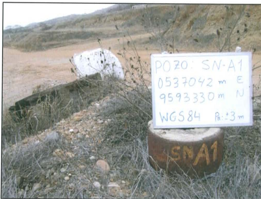
Fotografía N° 1. Se observa pozo inactivo con casing semienterrado de 12" de diámetro.
