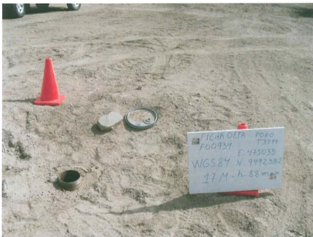
Fotografía N° 1. Vista pozo T3597 ubicado en una planicie, se observa el casing posiblemente cortado.
