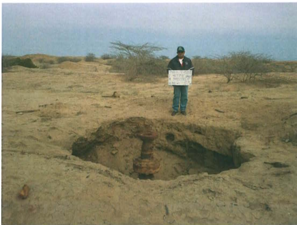
Fotografía N° 1. Pozo con código PETRUPETRO T1908 inactivo mal abandonado en el cual se encuentra dentro de un hoyo, con casing y brida corroida.
