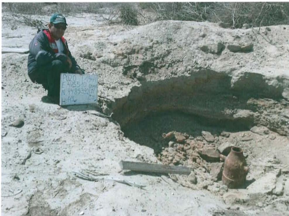
Fotografía N° 2. Pozo T1941, presenta casing expuesto dentro de una excavación de 1,5 m x 1,5 m x 1 m de profundidad aproximadamente.
