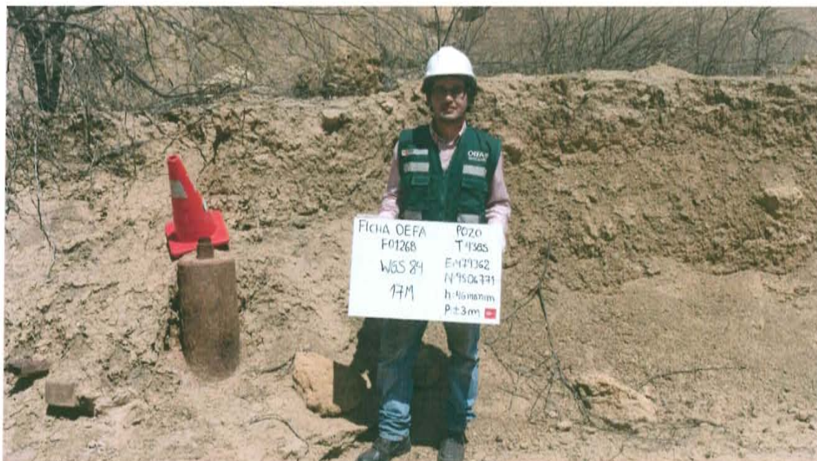
Fotografía N° 2. Pozo inactivo, con casing unido a una reducción expuesto, vista lado lateral de una colina.
